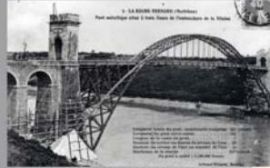
Pont de La Roche-Bernard, avec à gauche, fumée au vent, un ascif roulaube-compresseur en action. [Début 20 e siècle].
